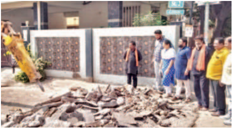
పనులను పరిశీలిస్తున్న కార్పొరేటర్ పాపనీ వినయకుమార్
